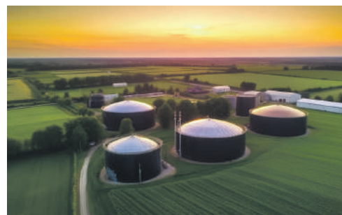
Мал. 41.8. Виробництво біогазу — суміші метану, водню та інших горючих газів — із відходів рослинництва та тваринництва
